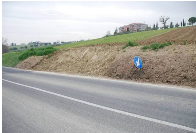
Fig. 5 - Smottamento di una scarpata stradale come risultato immediato dell'intervento di diserbo. Si noti come la frana abbia interessato esclusivamente il tratto di scarpata (al centro della foto) dove era stato realizzato il diserbo, lasciando integra la parte sulla sinistra ancora verde perché non interessata dal trattamento chimico (SP 362 Jesina, marzo 2010).
